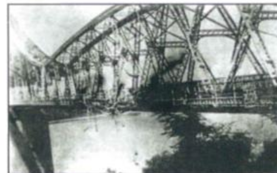
Разрушения Чернаводского моста
